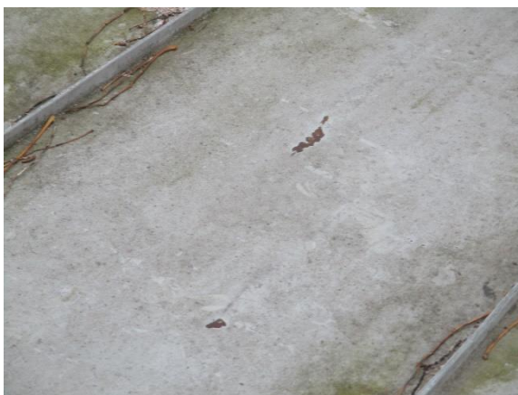
6.5 Vesikatteen maali- ja korroosiovauriota
