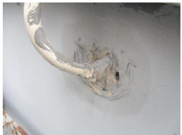
6.6 Lämpivientien elastiset tiivistykset ikääntyneitä
