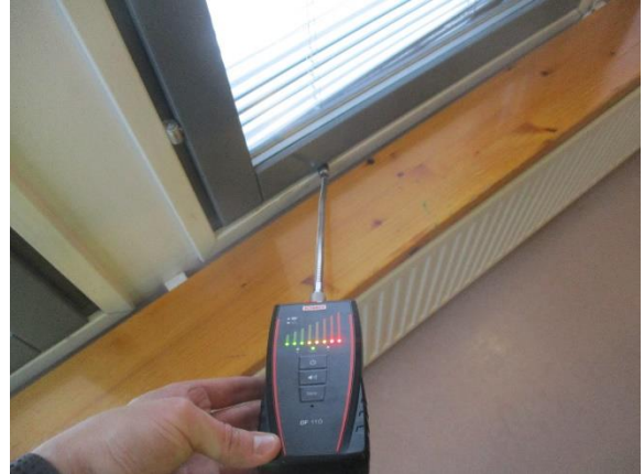
5.28 Ilmavuotokohta ikkunaliittymässä (pienryhmähuone)
