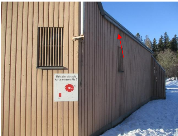
6.3 Yläpohjan tuuletusrako räystäällä
