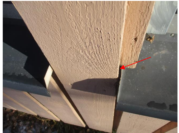
5.10 Julkisivun ja ikkunapellityksen liittymä ei ole tiivis
