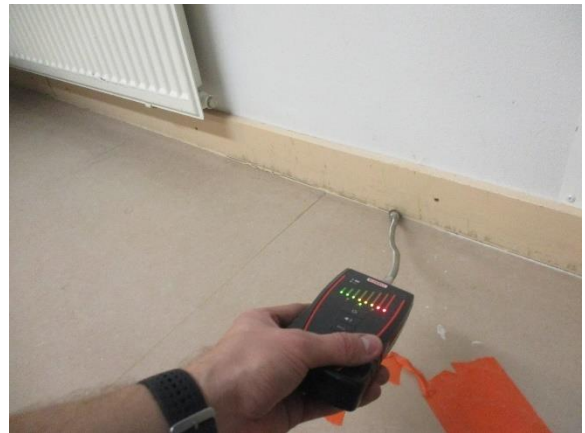
5.30 Ilmavuotokohta alapohjan ja ulkoseinän liittymässä (opetustila)
