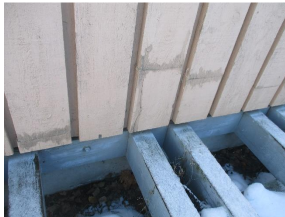
5.6 Julkisivulaudoitus on toteutettu paikoin lyhyillä laudoilla
