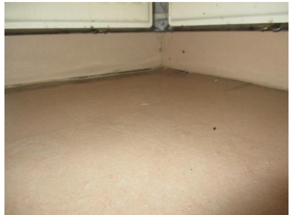
4.8 Lattialistan ja lattian liittymän elastinen saumaus rakoilee
