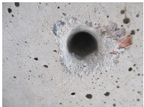
5.24 Sokkelin rakenneavaus (RA.01-SO)
