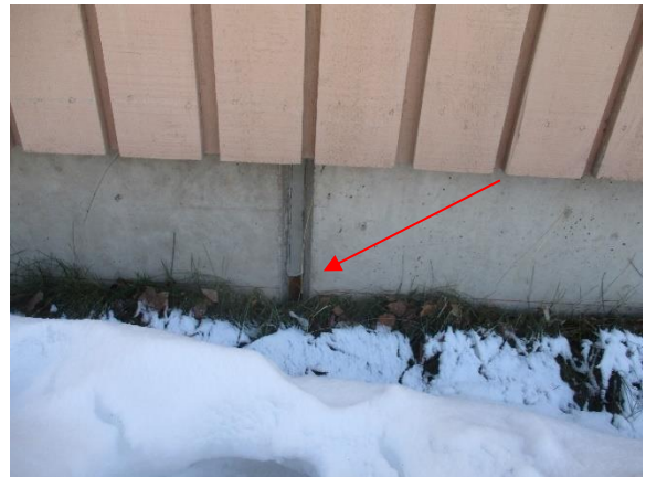
5.22 Sokkelin elastinen saumaus rakoilee (koillisjulkisivulla)
