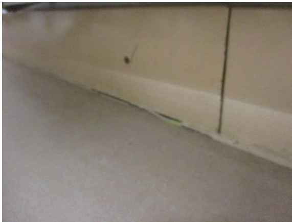
4.7 Lattialistan ja lattian liittymän elastinen saumaus rakoilee
