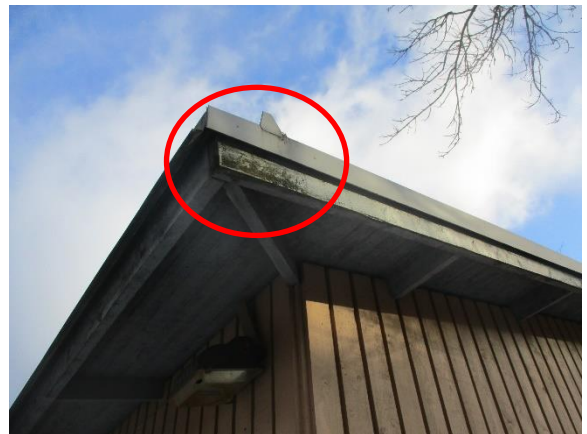
6.10 Räystäällä veden tulvimisjälkiä
