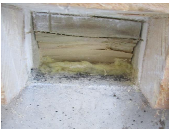
5.17 RA.04-US yhteydessä alajuoksupuun alla havaittiin vähäisiä määriä mineraalivillaa
