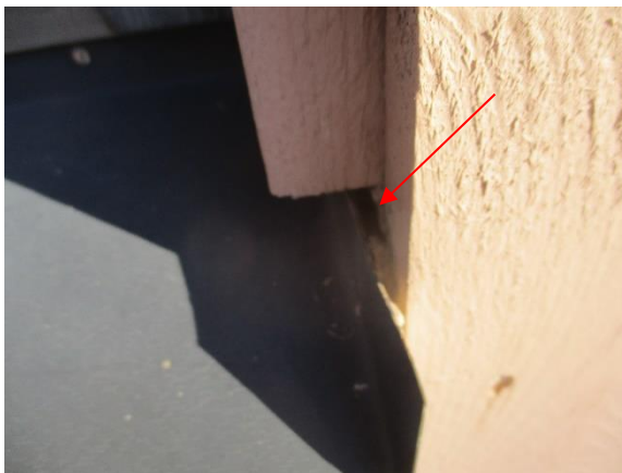
5.11 Julkisivun ja ikkunapellityksen liittymä ei ole tiivis
