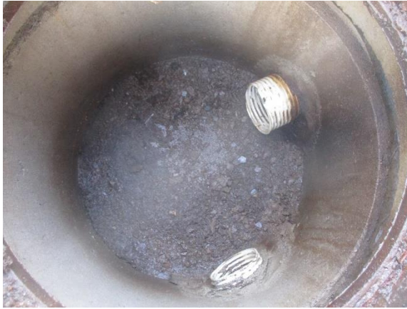
4.11 Salaojajärjestelmän tarkastuskaivo
