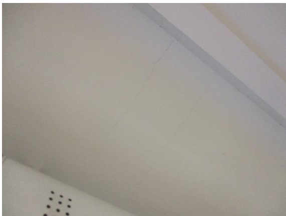
6.11 Sisäkattolevyssä halkeama (opetustila)
