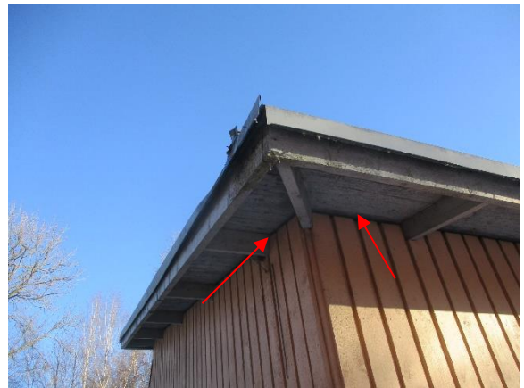
6.2 Yläpohjan tuuletusrako räystäällä
