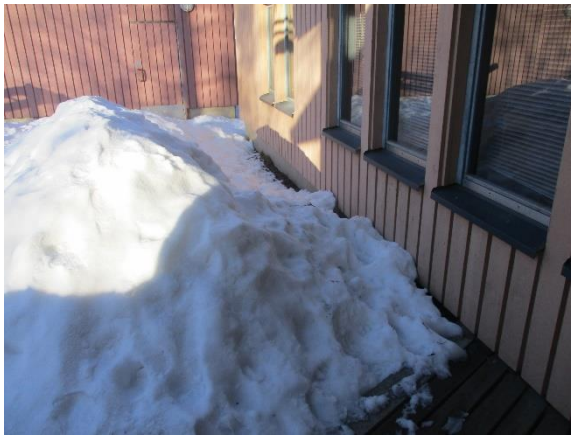
5.19 Lumet nojaavat julkisivulaudoitukseen sisäänkäynnin kohdalla
