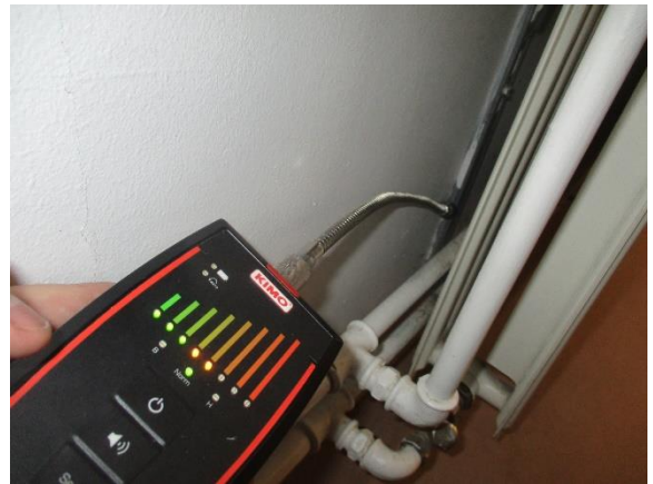
5.32 Ilmavuotokohta patterikiinnikkeen kohdalla (opetustila)
