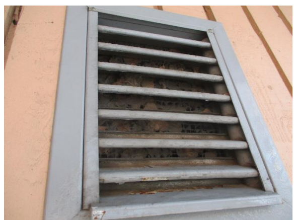
5.18 Ulkoilmasäleikkö täynnä lehtiroskaa
