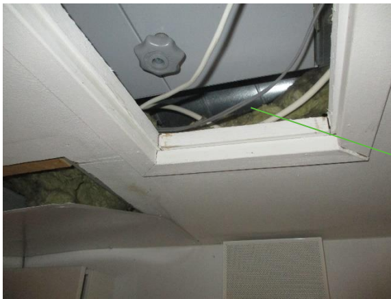
6.15 IV-kanavan kohdalla sisäkatossa mineraalivilla näkyvillä
