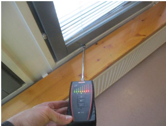
5.29 Ilmavuotokohta ikkunaliittymässä (pienryhmähuone)
