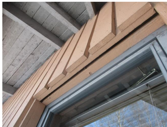
5.4 Julkisivun tuuletusrako ikkunan kohdalla
