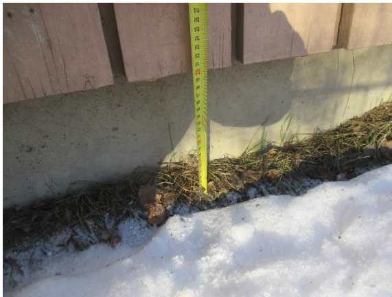
5.21 Matala sokkelirakenne (<200 mm)
