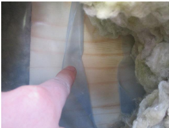
5.15 Höyrinsulkumuovi ei ole tiivis (RA.02-US)
