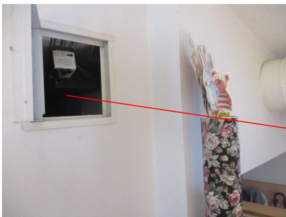
6.17 IV-kanavan kohdalla sisäkatossa mineraalivilla näkyvillä
