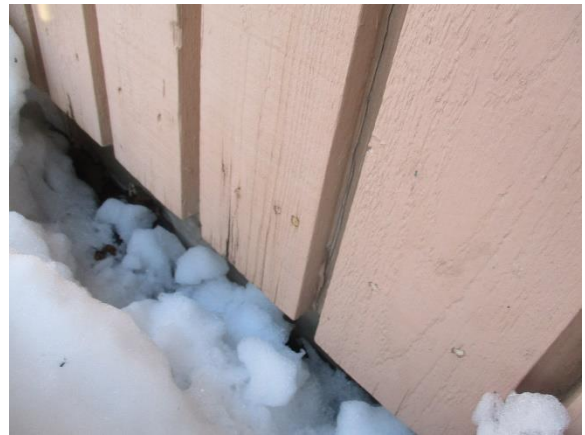
5.20 Matalan sokkelirakenteen vuoksi laudoitus kiinni lumessa ja laudoituksessa haristumaa (lounaisjulkisivu)
