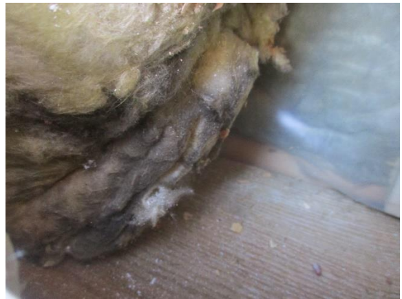
5.14 Ulkoseinän lämmöneristeessä todennäköisesti ilmavuotojen aiheuttamaa tummentumaa (RA.03-US)
