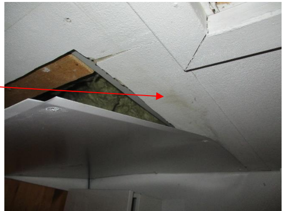
6.14 Eteisen sisäkatossa todennäköisesti vanhoja vesivuotojälkiä
