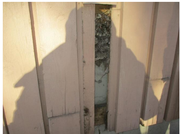
5.12 Julkisivun tuuletusvälissä vanha ampiaispesä (RA.02-US)
