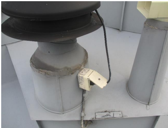
6.7 Läpivientien elastiset tiivistykset ikääntyneitä
