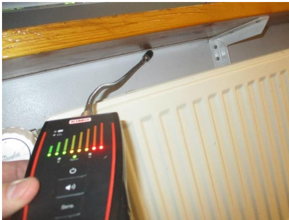
5.31 Ilmavuotokohta ikkunaliittymässä (opetus-tila)
