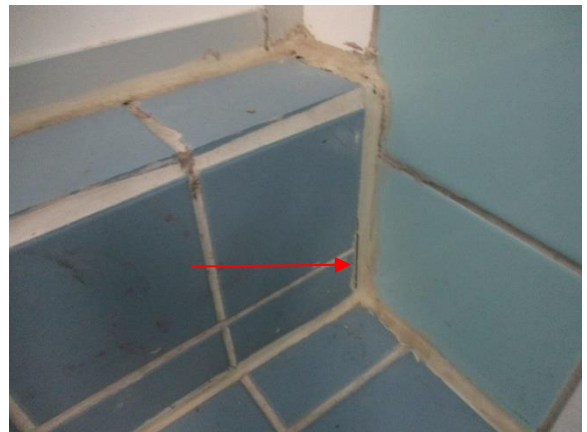
4.10 Märkätilan elastisten saumaukset rakoilevat
