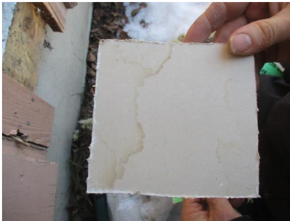
5.13 Tuulensuojalevyssä kosteusjälkiä (RA.03-US)
