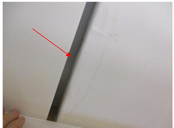
6.12 Akustiikkalevyssä tummentumaa, sisäkattossa ei vaurioita (opetustila)
