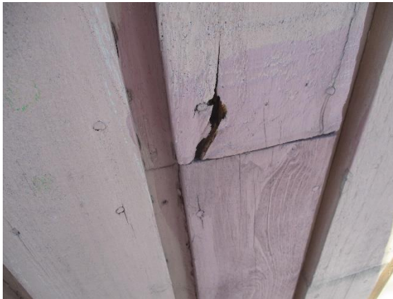
5.9 Julkisivulaudoituksen lohkeama ja maalipinnan kulumaa
