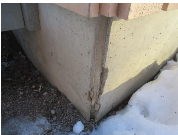
5.23 Sokkelissa lohkeama sekä elastisen saumaus rakoilee (lounaisjulkisivu)
