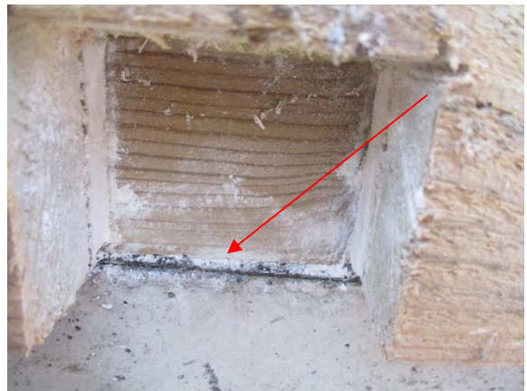
5.16 Alajuoksupuun ja sokkelin väliin on asennettu suunnitelmien mukainen bitumikermi
