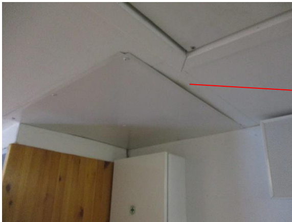
6.13 Eteisen sisäkatossa todennäköisesti vanhoja vesivuotojälkiä
