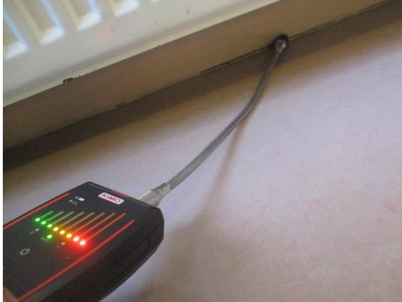
5.27 Ilmavuotokohta ulkoseinän ja alapohjan liittymässä (pienryhmähuone)
