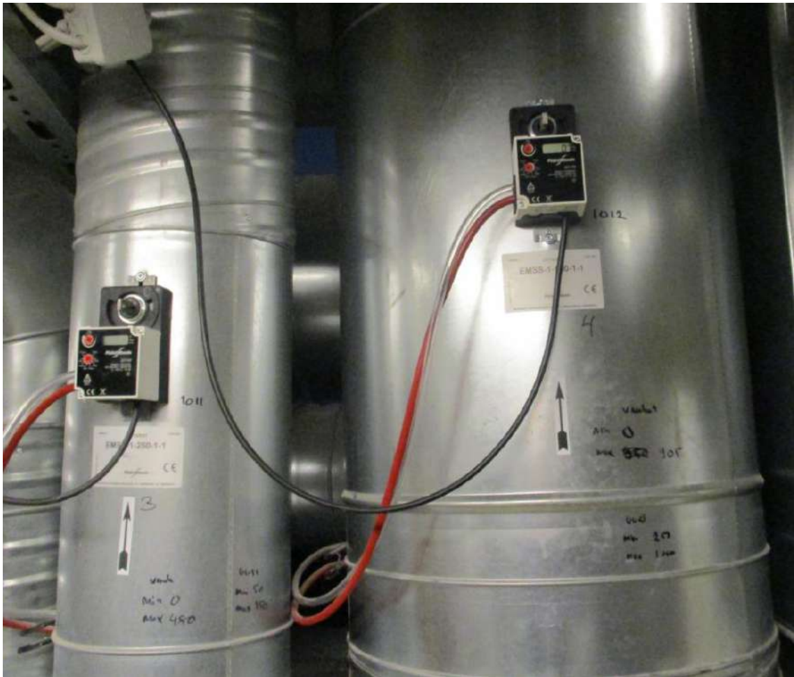
Kuva 2. Ilmavirtasäädin, IMS, Fläktwoods.
