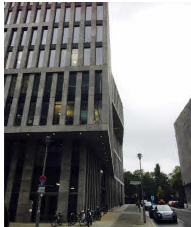
Rautatieaseman viereisiä hotelli- ja toimistorakennuksia
