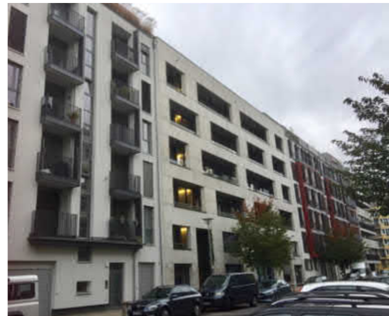
Uutta täydennysrakentamista alueella.
