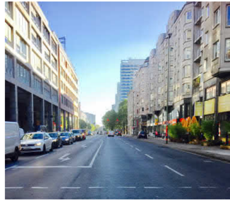
Katutila on hallitseva alueella ja rakennukset muodostavat katujen ympärille muurimaisen tasakorkean massan.
